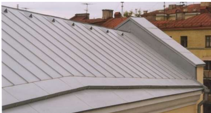
Мал. 2 – Фото покрівлі із фальца з настінним жолобом
